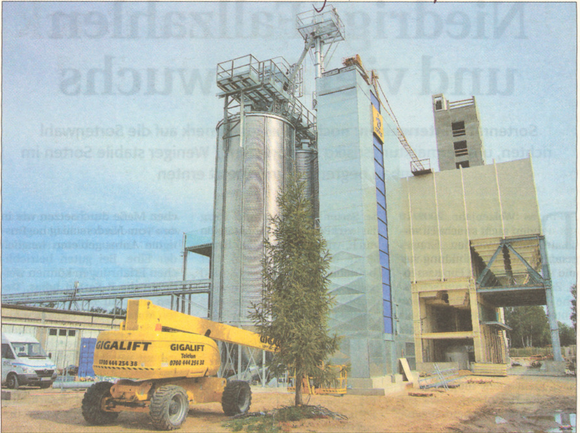
Noch ist das künftige Futtermittelwerk eine Baustelle. Schon im Dezember sollen hier neben Roggen, Weizen, Gerste, Triticale auch Erbsen und Lupinen aus den Biopark-Betrieben vermahlen werden. FOTOS: SILKE ECKARDT, PRIVAT
